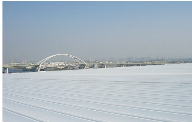
物流倉庫屋根
