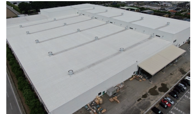
自動車メーカー外壁・屋根
