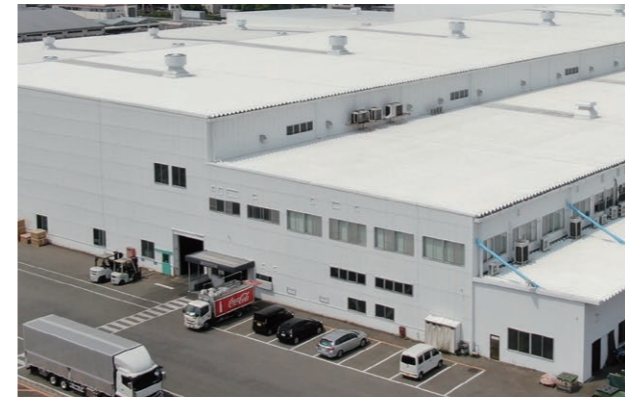
自動車メーカー外壁・屋根
