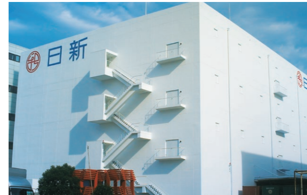
冷蔵倉庫外壁・屋根
