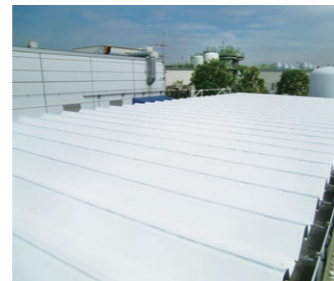
建物構造:鉄骨造、カラー鋼板屋根、結露防止用断熱材4mm 温度測定:屋根裏面および上部室内温度を連続記録温度計にて実測
