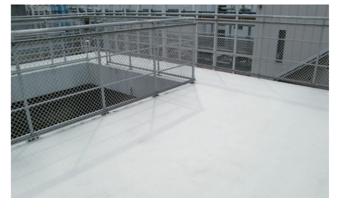
化学メーカー屋上
