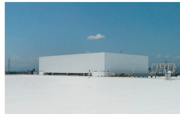
食品卸ビル屋上
