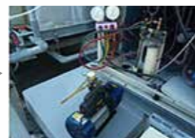
真空引き、冷媒再充填、試運転
