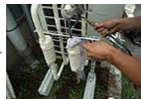
液管側に「冷媒リアクターパイプ」接続
