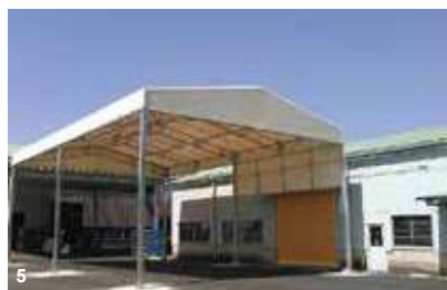
5. テント上屋：不燃膜の表面をフッ素コーティングしており、通常より防汚効果があります。6. テント屋根：既存のコンクリートの仕切り壁の歪みも、1本1本の梁の長さを変えて既存の寸法に合うよう設計・施工しました。
