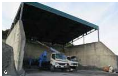
5. テント上屋：不燃膜の表面をフッ素コーティングしており、通常より防汚効果があります。6. テント屋根：既存のコンクリートの仕切り壁の歪みも、1本1本の梁の長さを変えて既存の寸法に合うよう設計・施工しました。
