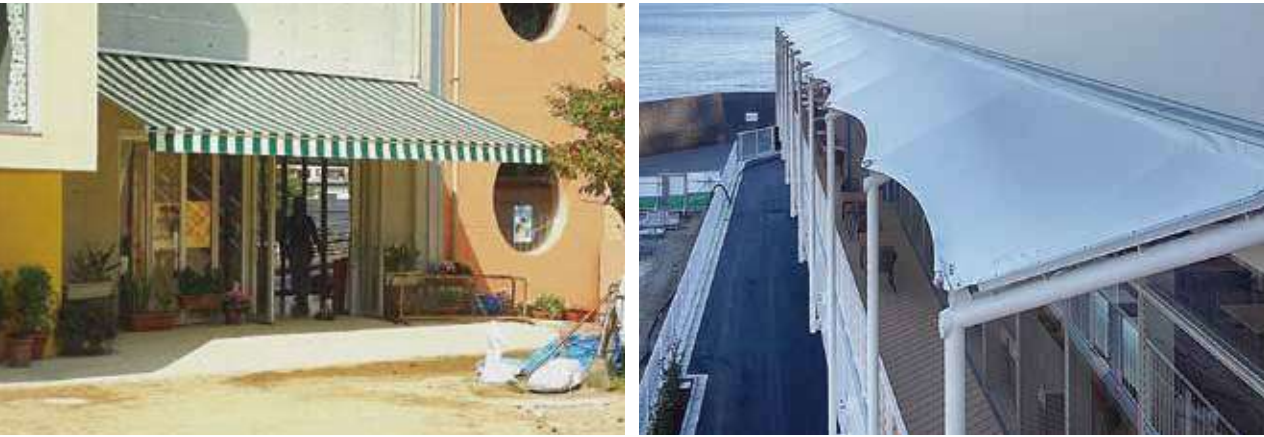
太陽光の侵入を防ぎ、エアコン稼働率を下げることで消費電力を削減し、省エネ効果が期待できます。
