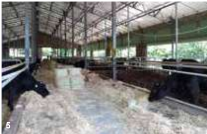
4. 膜構造畜舎は、用途によって膜素材を変更でき機能的です。5. 牛舎は、取り扱う牛の種類によって、遮光と採光のどちらを選択するか悩ましいものですが、透光率の違う膜素材を使用することでその悩みを解消します。
