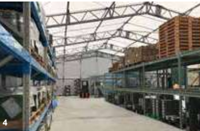
4. 資材のストックヤード：テント倉庫は内部に柱が無いので自由度が高く、高さも軒高5mの設計で大量の保管が可能です。5. トラック中継場テント倉庫：作業の際に雨に濡れないよう、出巾3.45mの大きな庇を付けました。
