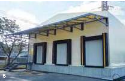
4. 資材のストックヤード：テント倉庫は内部に柱が無いので自由度が高く、高さも軒高5mの設計で大量の保管が可能です。5. トラック中継場テント倉庫：作業の際に雨に濡れないよう、出巾3.45mの大きな庇を付けました。
