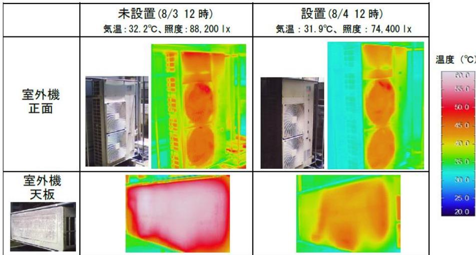
図 室外機表面温度のサーモグラフィー (実証対象製品設置時の天板は、直前にネットを外してから撮影した。)
