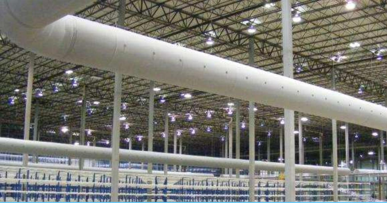
ダクトソックスは空調機につなぐ布製のダクトで、端から端まで吹出穴を加工することができ、ダクト全体から空気を吹き出します。
